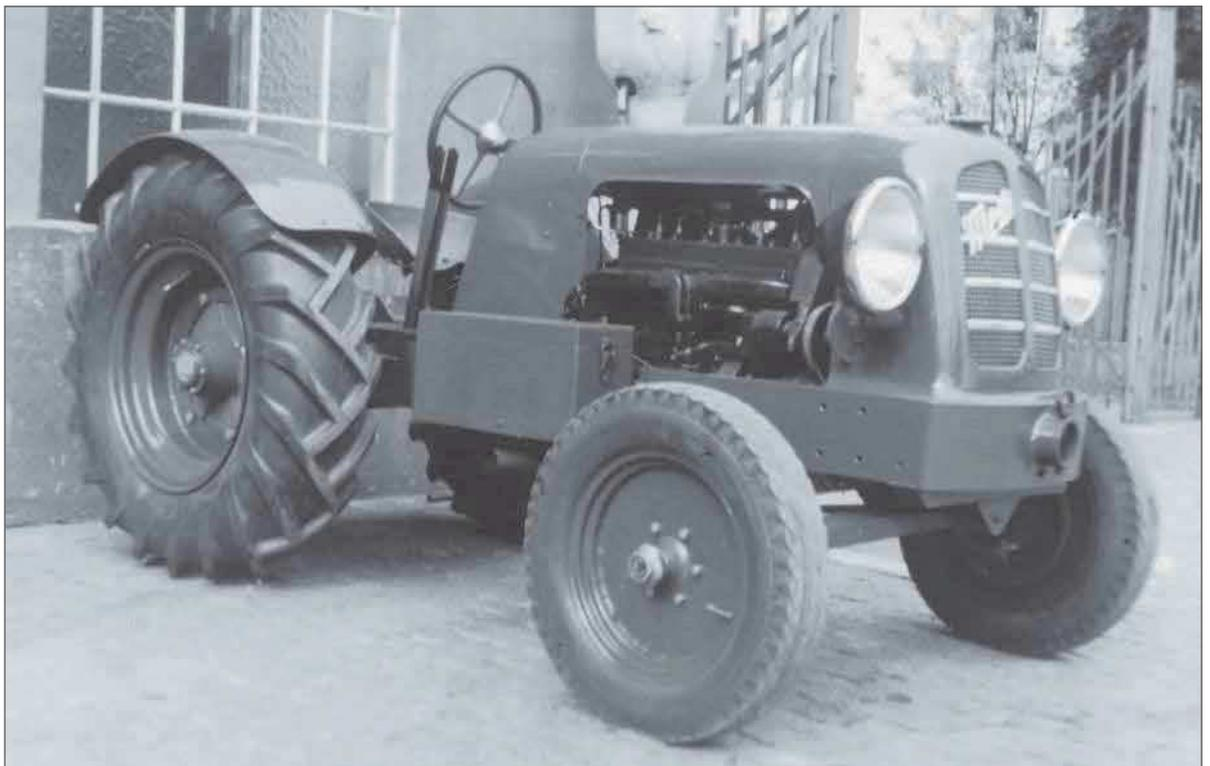
standard I oder den Meili-Spezial I mit 50 PS starken Chrysler-Motoren an. Für den Grossbetrieb stand der Meili-Standard II oder der Meili-Spezial II mit 80 PS starken Chrysler-Motoren zu Verfügung.
